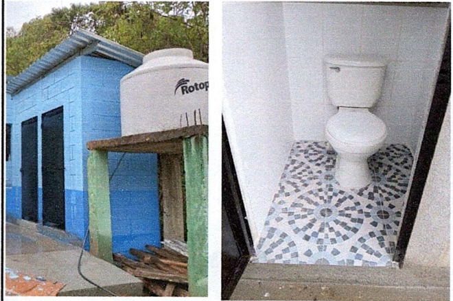
Foto 4: finalización de servicios sanitarios
