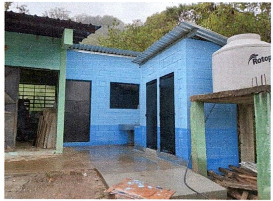
Foto 2: finalizada con puertas y ventanas de la cocina
