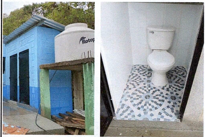
Foto 4: finalización de servicios sanitarios
